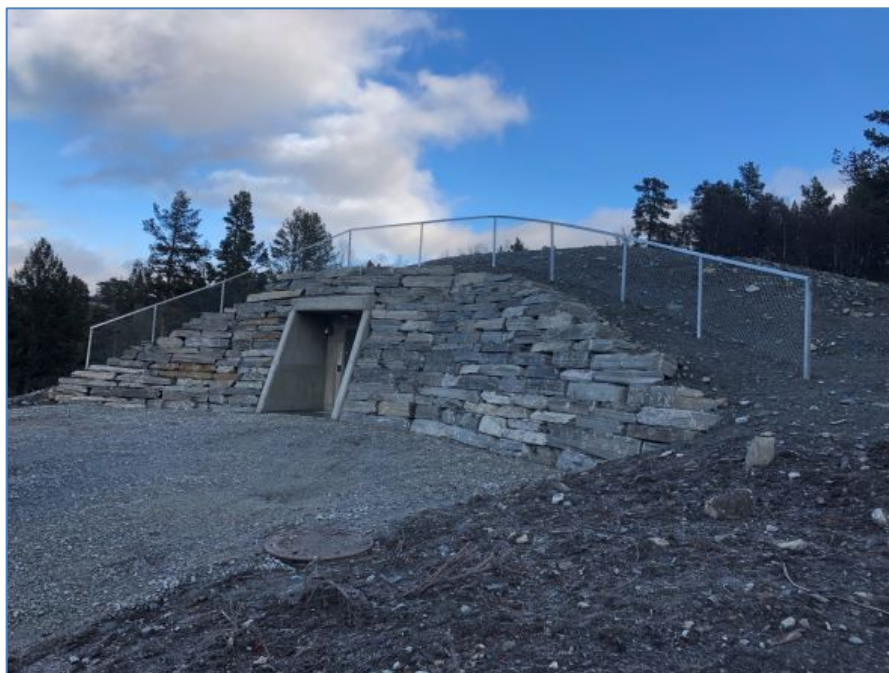
Figur 9.16 Møllehaugen høydebasseng, fasade/inngangsparti
